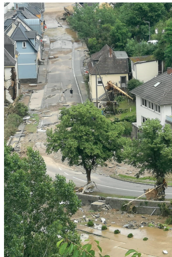
Das Ausmaß der Zerstörung in Altenahr: Hier stand das Wasser teilweise acht Meter hoch.
